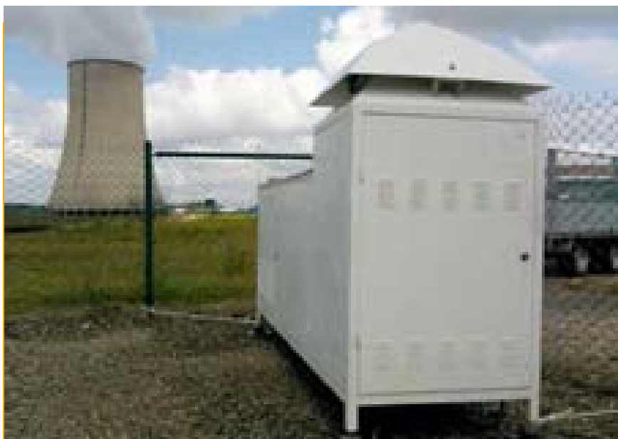
Figure IV.69 - Préleveur Opera-Air (300 m 3 /h) installé sous les vents dominants du CNPE de Golfech.
