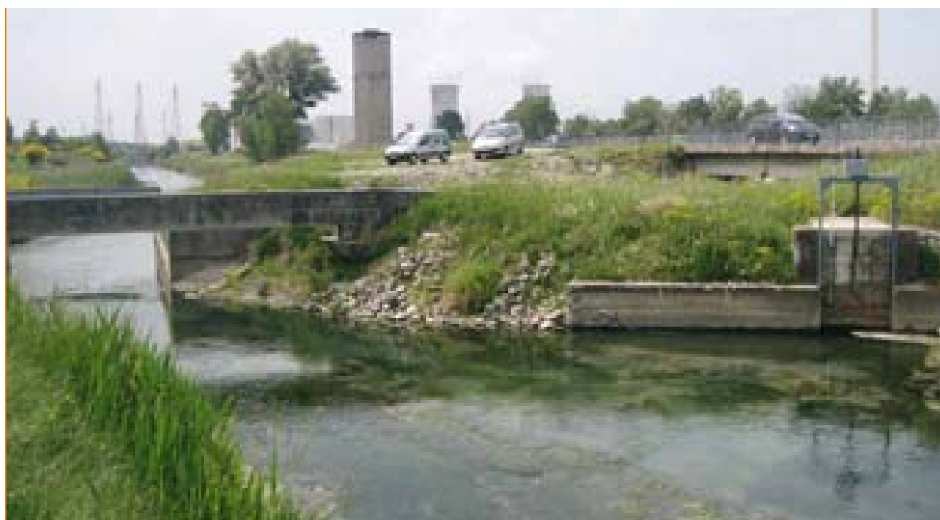
Figure V.25 - Contre-canal rive droite en amont du site nucléaire du Tricastin.
